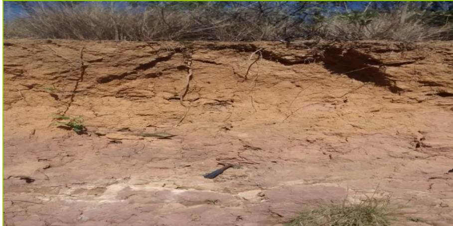
Figura 27: Perfil de solo exposto em face escavada por fluxo hídrico fluvial.
