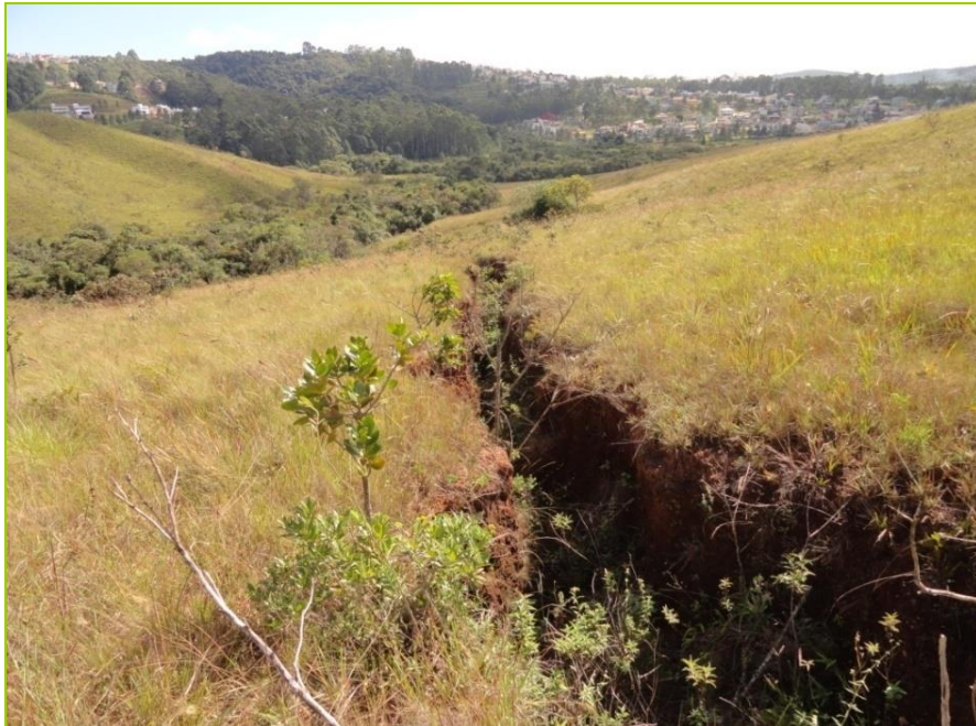
Figura 24: Erosão linear em direção a calha do córrego da Matinha. Coordenadas: 20°10'42.05"S / 43°56'1.90"O – WGS.
