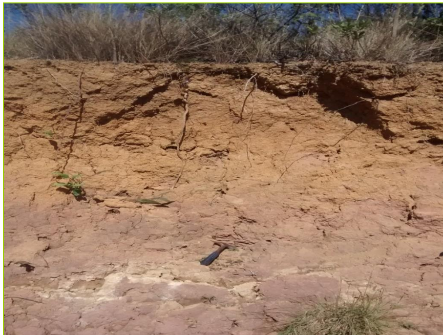
Figura 91: Perfil de solo exposto em face escavada por fluxo hídrico fluvial.
